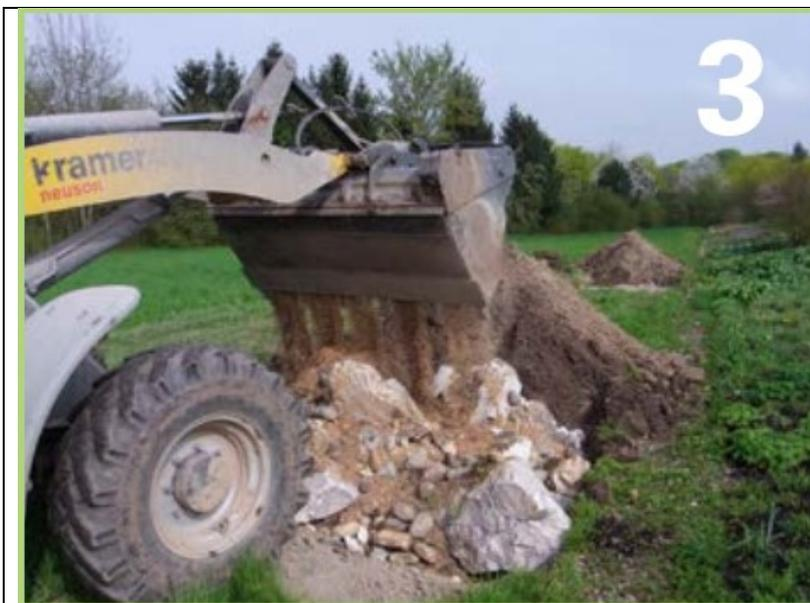
Kiesschüttungen und Bruchsteine mit unbehandeltem, sauberem Material (kein Bauschutt), auch der Einbau von Wurzelstubben ist möglich.
