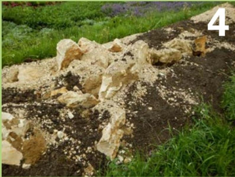
Grobes Material (unten) wird mit feinerem Material (oben) verfüllt. Der Oberboden wird in den Randbereichen wieder eingebaut
